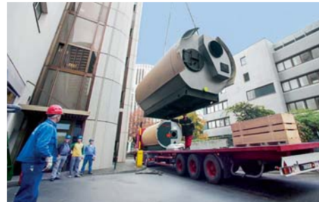
Anlieferung eines Vitomax Kessels auf der Baustelle
